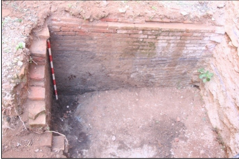
F7.- Dipòsit UE 12 que trobem a la Rasa 2.
