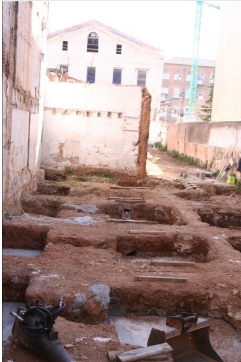
F17.- Foto final del cantó Nord la intervenció.
